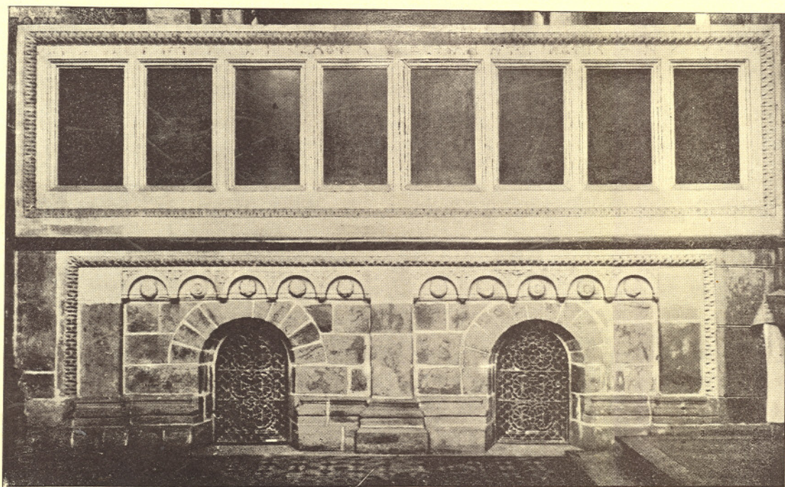
Zuidelijke zijmuur der crypte.
