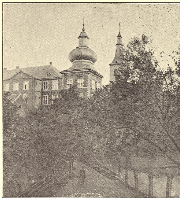
Noordwestelijke gevel van Rolduc.
