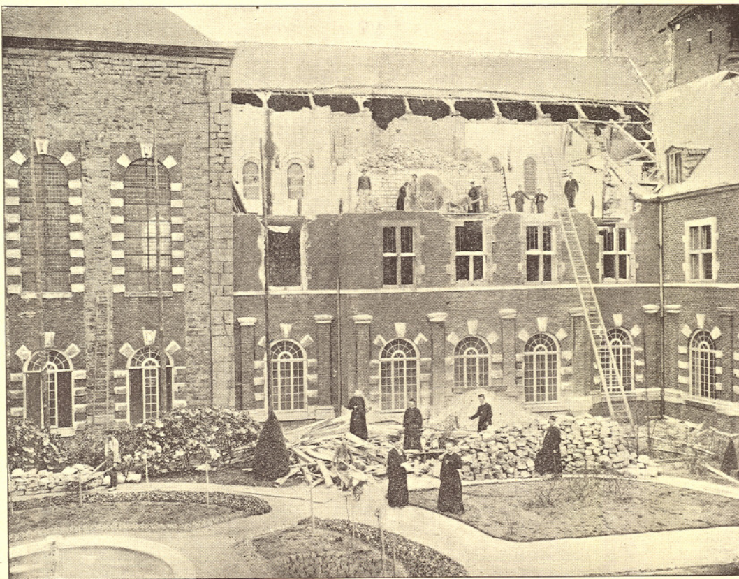
Herstellingswerk aan den noordgevel der Kerk.
