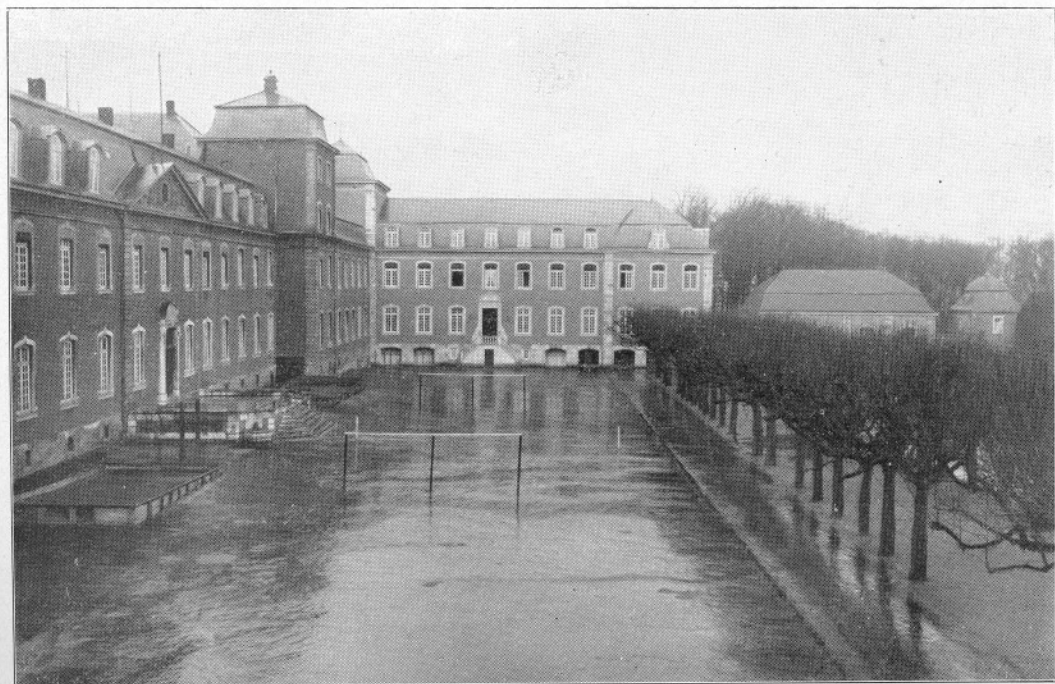
OOSTGEVEL MET NOORDERVLEUGEL 1926
